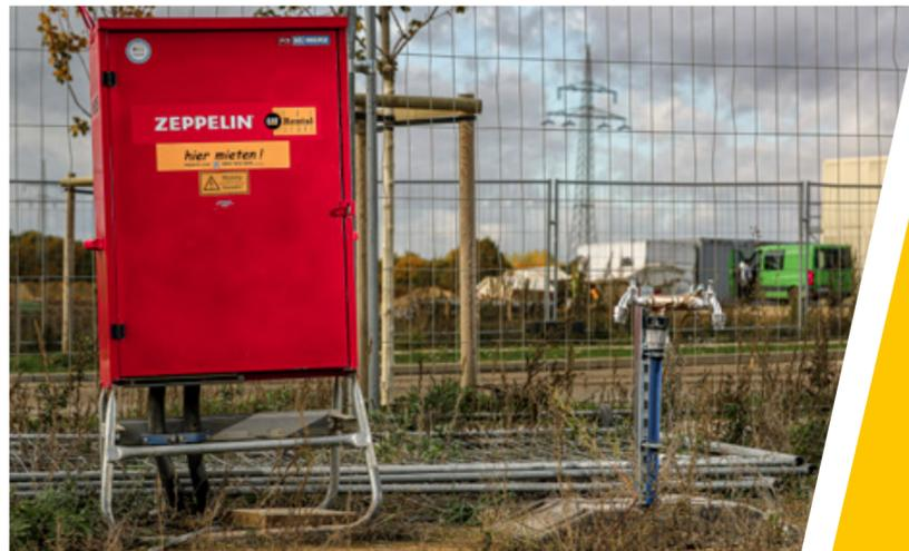
Wasser marsch: Entlang des Baufelds befinden sich Bauwasserverteiler für verschiedene Gewerke
