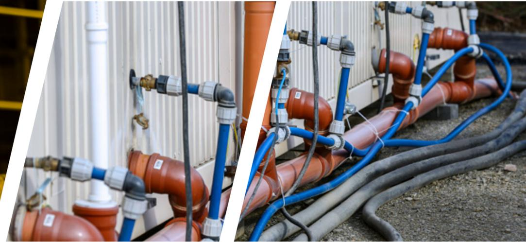
Containeranschlüsse mit innenliegender, selbstregulierender Rohrbegleitheizung als zuverlässiger Frostschutz
