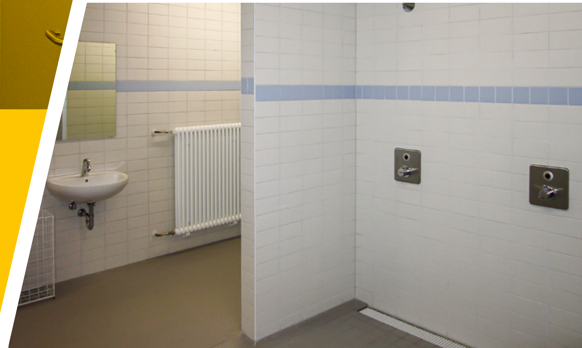
Der offene Duschbereich mit rutschhemmenden Bodenfliesen
