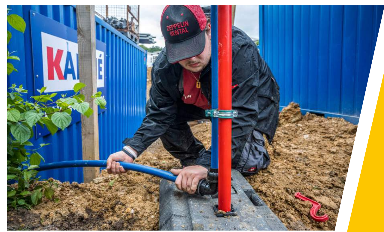
Ist die Zapfstelle installiert, fließt Wasser in Trinkwasserqualität.
