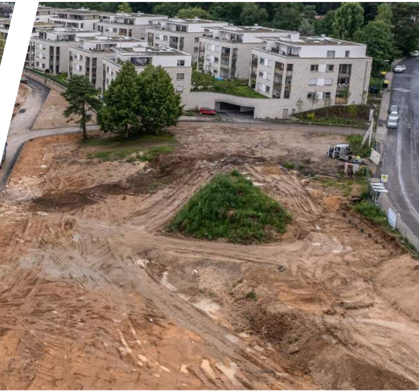
264 Wohnungen entstehen im sogenannten Waldviertel.
