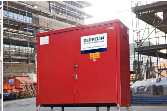
Über eine Trafostation, 5,6 Kilometer Gummischlauchleitung und 99 Baustromverteiler wurde die Baustelle mit Energie versorgt.
