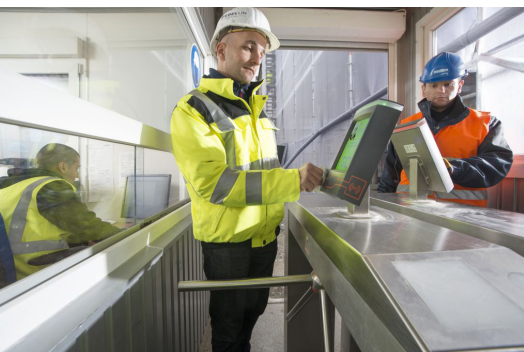
Das Zutrittskontrollsystem Zeppelin InSite 3.0 überwacht alle Personenströme und prüft Berechtigungen online.
