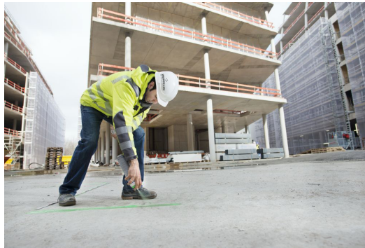
Ein Baulogistiker markiert die Lagerflächen, damit die benötigten Materialien immer gleich verfügbar sind.
