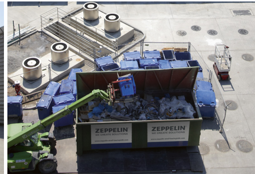
Es wurde auf dem engsten Raum Baumischabfall in Containern gesammelt und entsorgt.
