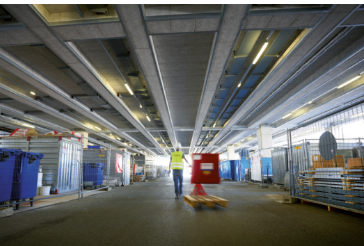
27 Kilometer Kabel, Trafostationen und rund 300 Schaltschränke wurden verlegt.
