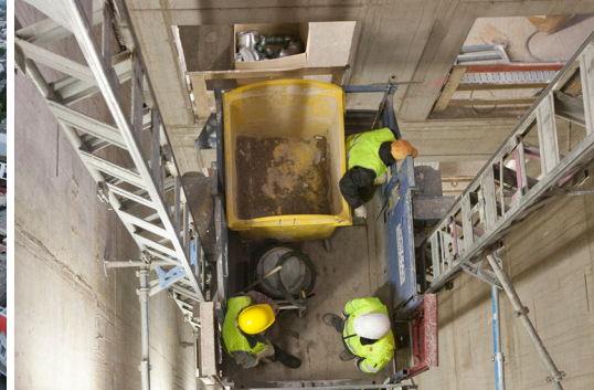
Vier Aufzüge mit Fahrern standen auf dem Bauvorhaben zur Verfügung.
