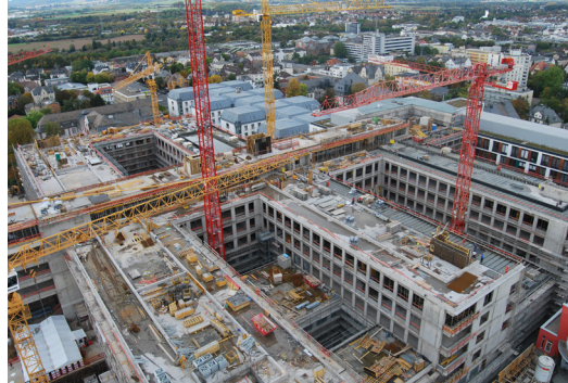
Auf dem riesigen Baufeld mitten auf dem Klinikgelände spielte die Koordination der logistischen Abläufe eine wichtige Rolle.
