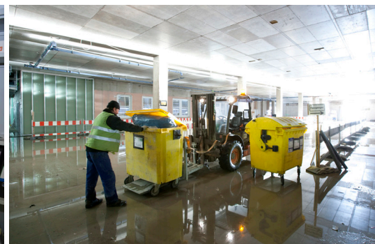
Das Entsorgungskonzept der Baulogistiker schaffte Platz und sorgte für freie Zufahrtswege.
