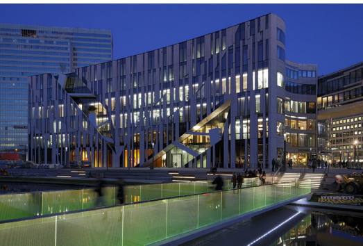
Mit der Baulogistikplanung wurden Material- und Personenbedarf ermittelt, sowieso Anzahl an PKW & LKW errechnet.
