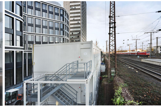
Die detaillierte Planung der Baustelleneinrichtung sorgte für optimale Ausnutzung des Platzes.
